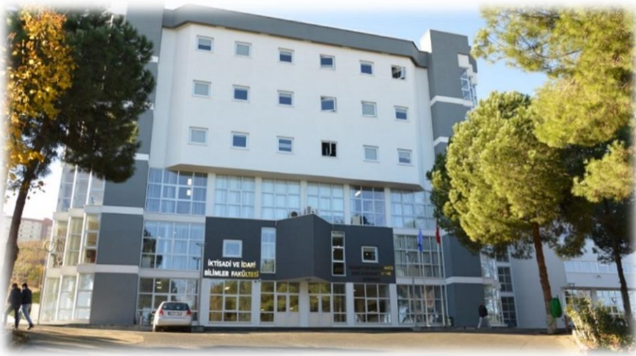
Fakülte Binası İdari Blok
