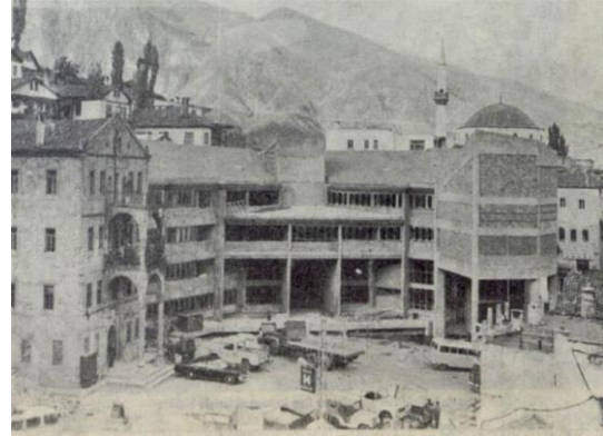
Ek 11. Artvin Eski ve İnşaat Halindeki Yeni Hükümet Konağı Binaları
