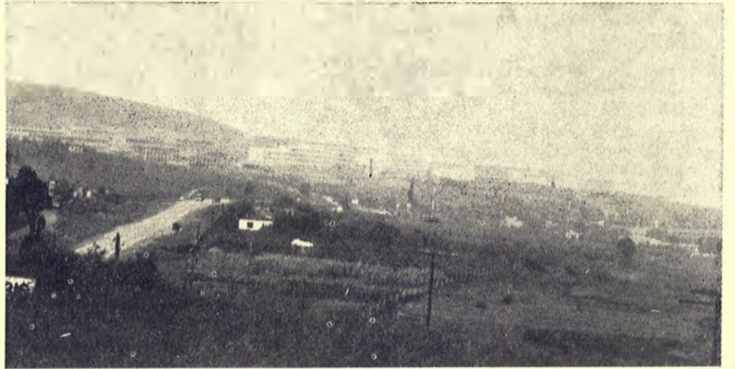
Öğretim Binalarının genel görünüşü.
