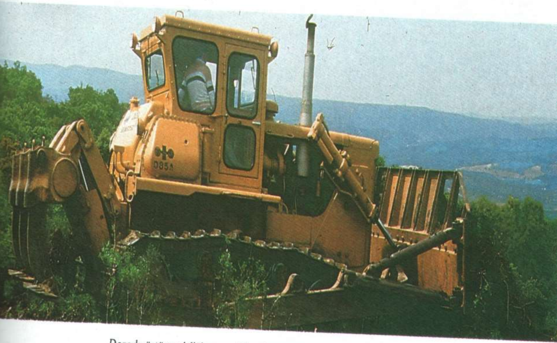
Dozerle örtü temizliđi ve arazi hazırlama çalışması / O.G.M. Arşivinden
